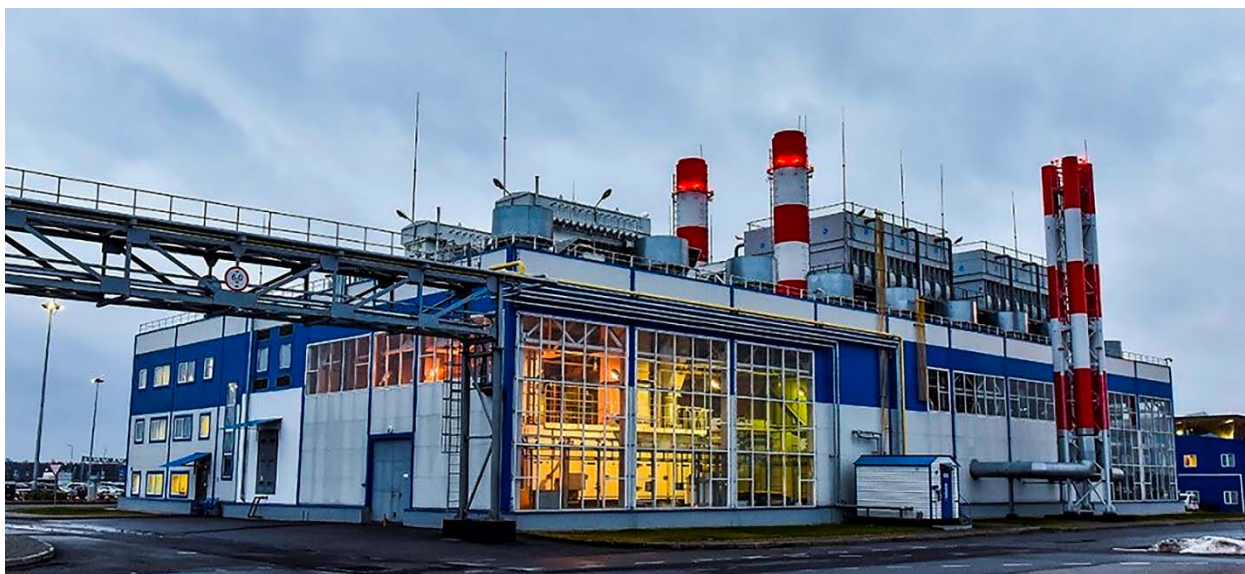
Рисунок 1 – Тригенерационный энергокомплекс аэропорта Пулково, г. Санкт-Петербург
